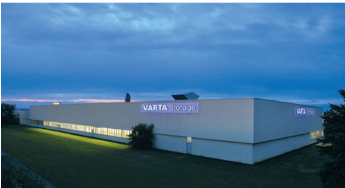
Produktionshalle von VARTA Storage
